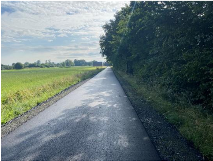
Abb. 22: Erfolgreiche Deckensanierung Mähnenstraße. Foto: Stadt Selm
