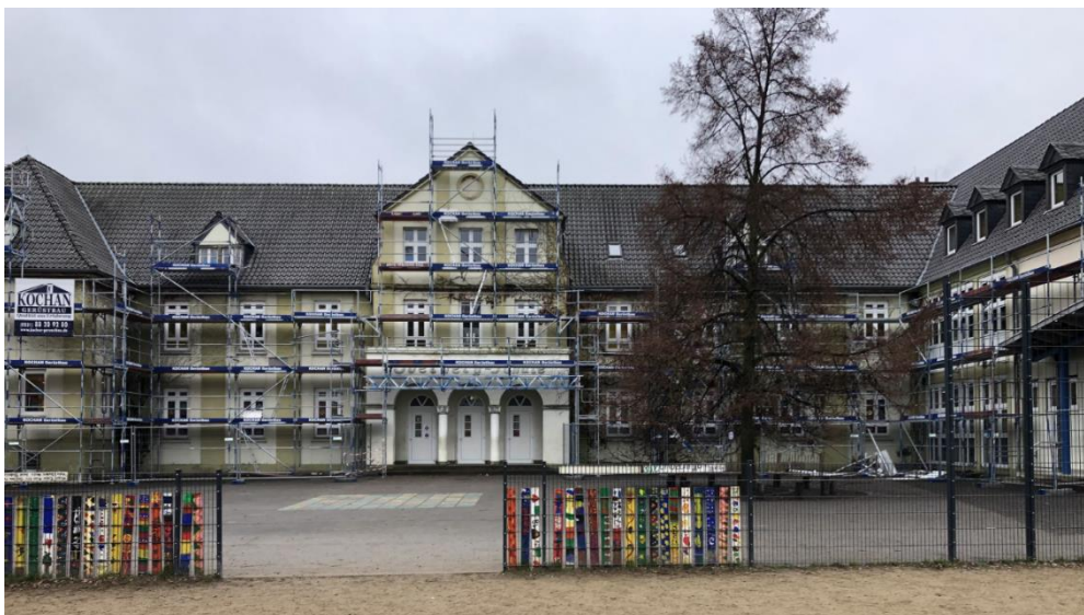
Abb. 19: Energetische Sanierung der Overbergschule in Selm. Foto: Stadt Selm.
